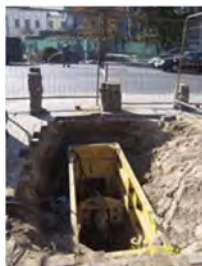
Установка в боксе
