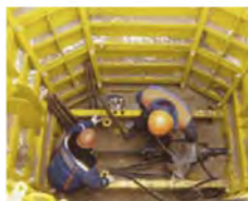
Монтаж МНБ-50 в опалубке ОР-1,5
