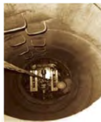
Установка в колодце с КРС
