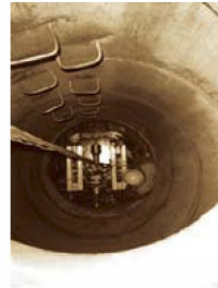
Установка в колодце с КРС
