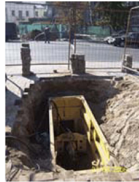
Установка в боксе
